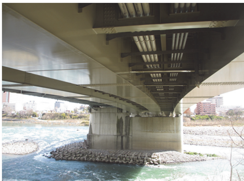
完成【17号 群馬大橋(塗装塗替)】 東京方面より新潟方面を臨む
