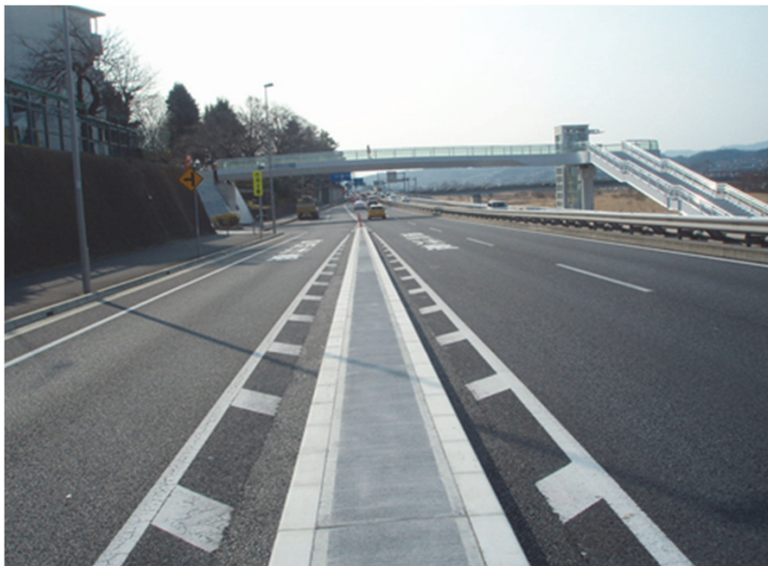
完成【国道17号(中央分離帯工)】 上り線 前橋側から東京方面を臨む
