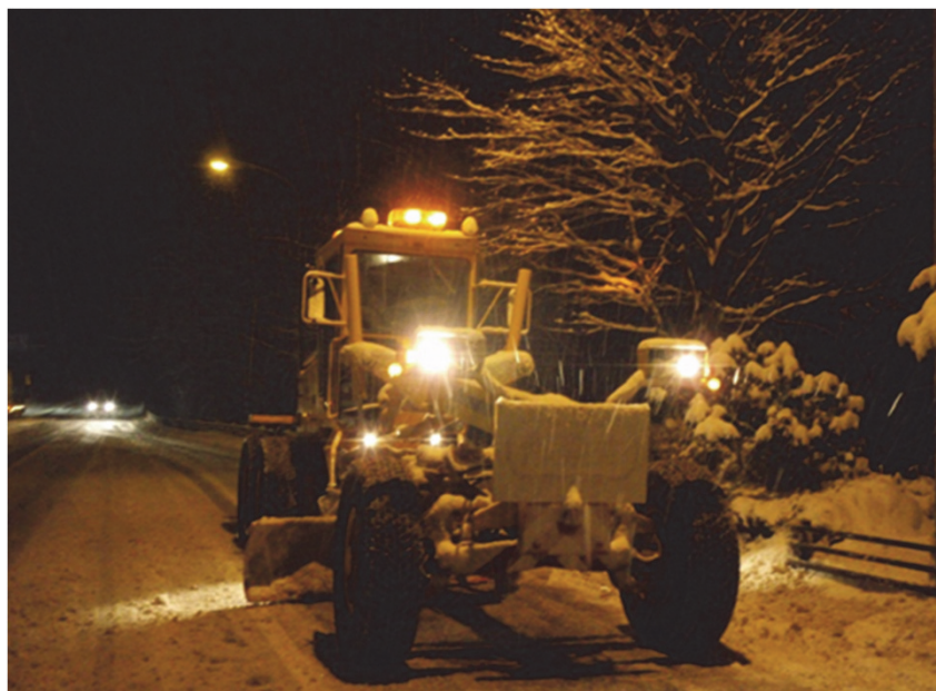
施工状況【国道18号(碓氷BP)(除雪作業)】
