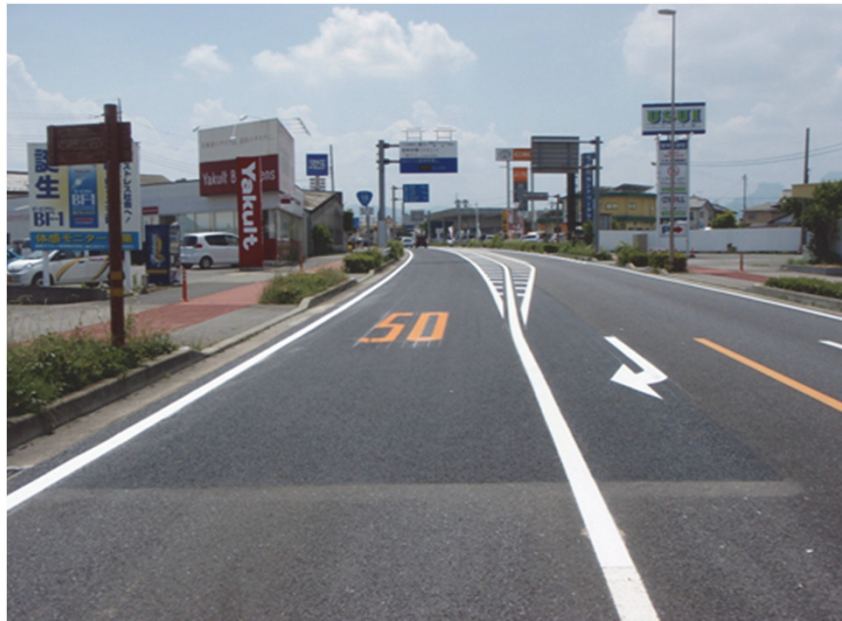
完成【国道18号(切削オーバーレイ工)】 下り線 高崎側から長野方面を臨む
