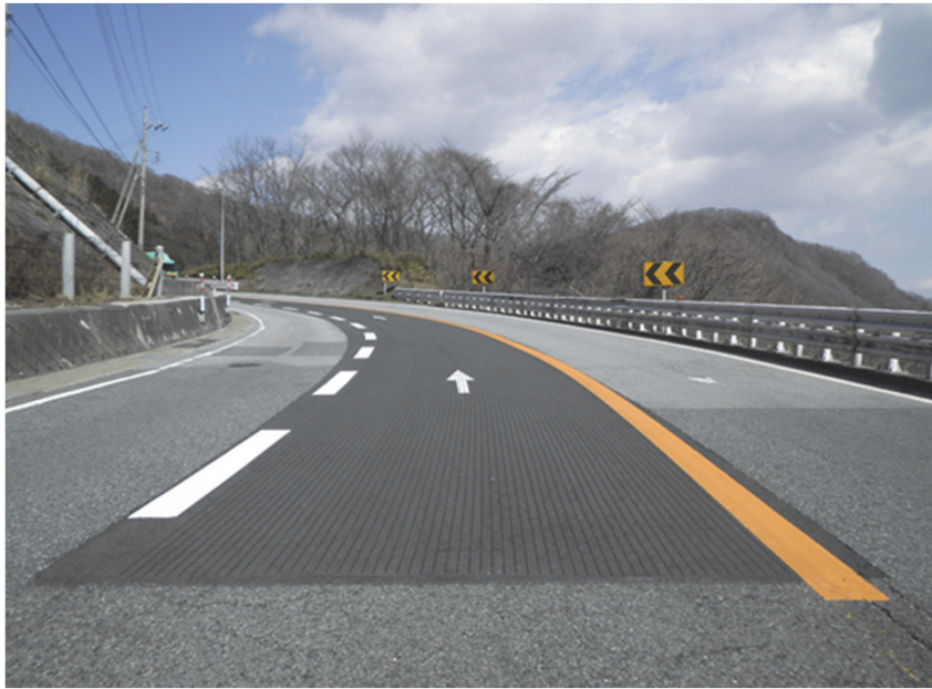
完成【国道18号(碓氷BP)(凍結抑制舗装工)】 下り線 高崎側から長野方面を臨む
