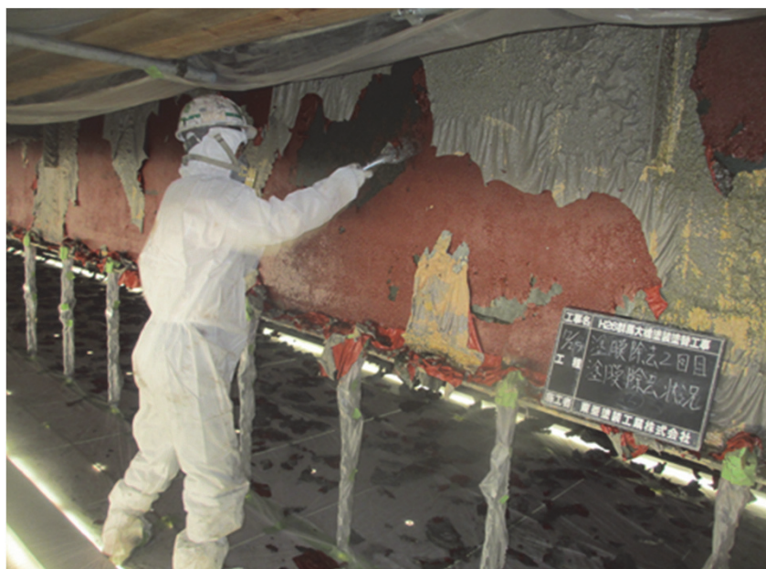
施工状況【17号 群馬大橋(既設塗膜の除去)】
