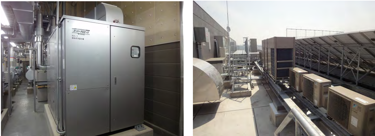
完成又は施工状況写真
