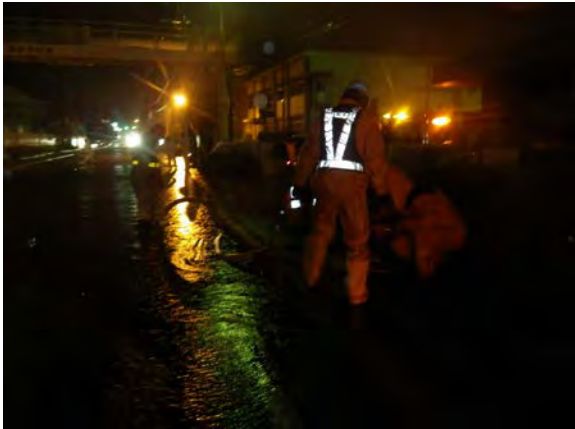
施工状況写真(道路冠水)
