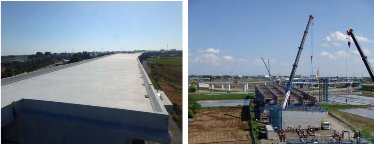
完成又は施工状況写真
