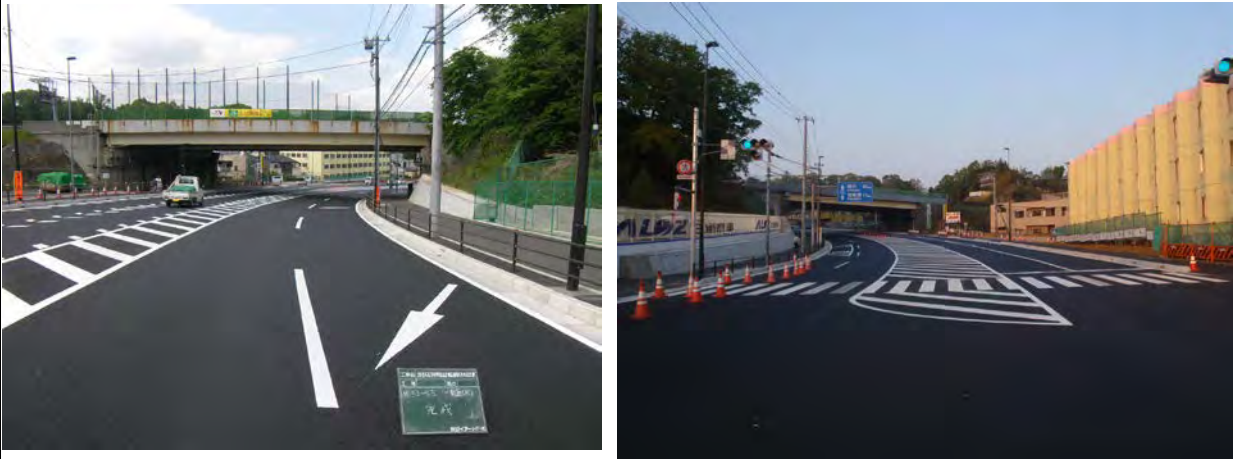
完成又は施工状況写真
