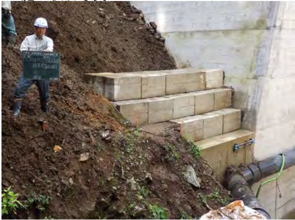
施工状況写真
