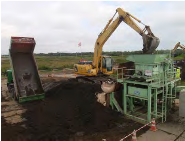
土質改良工作業
