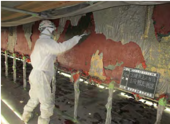
〔剥離剤塗布後の塗膜除去作業〕
