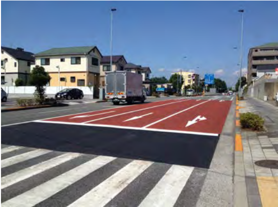
完成又は施工状況写真
