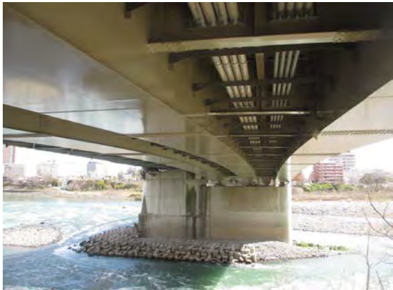
〔塗装塗替(完成)〕
