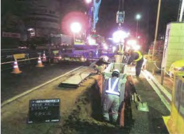
特殊部設置状況
