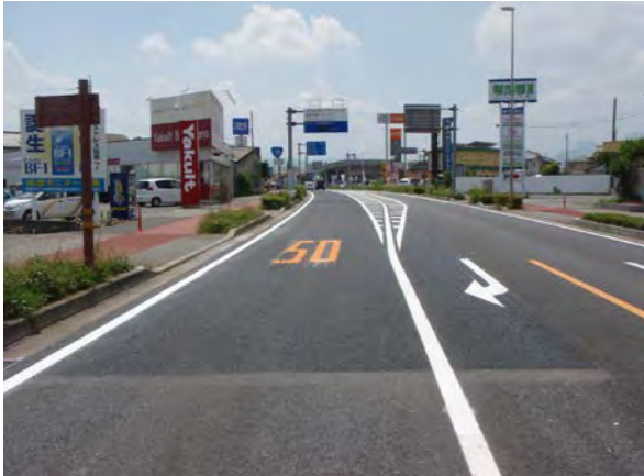
完成又は施工状況写真
