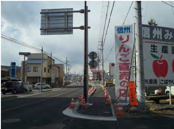
完成又は施工状況写真
