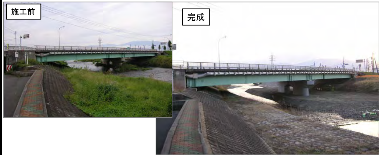
完成又は施工状況写真
