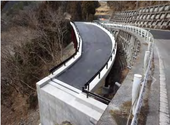
完成又は施工状況写真
