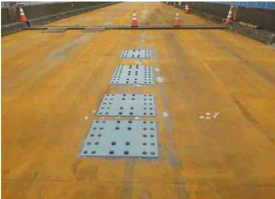
完成又は施工状況写真
