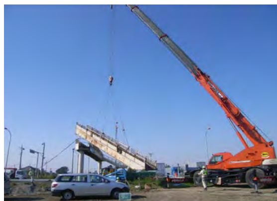
施工状況(歩道橋の撤去)
