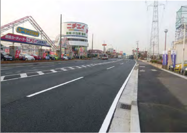
本復旧後の状況
