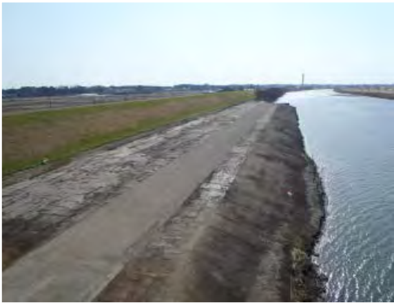
完成(覆土完了)
