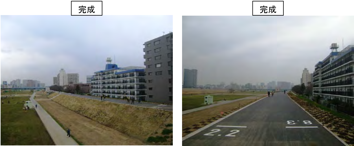
完成又は施工状況写真
