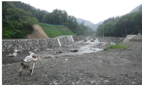
写真-5 起工測量の様子=6月23日、H27関守左岸護岸他整備工事現場
