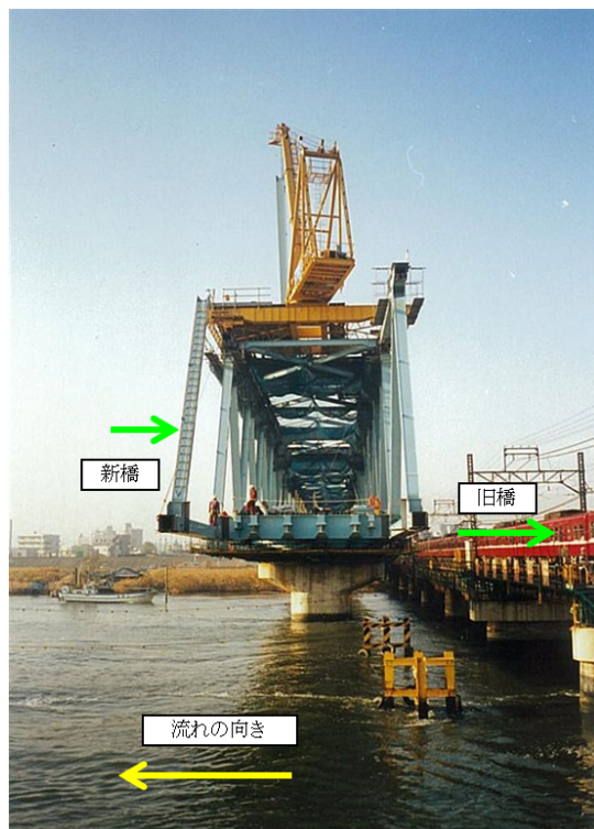
図4 架替工事の状況
