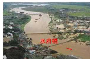
水府橋付近(水戸市)の氾濫状況
