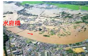
水府橋付近(水戸市)の氾濫状況
