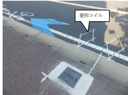
図-6 計測システム設置状況(車道部)
