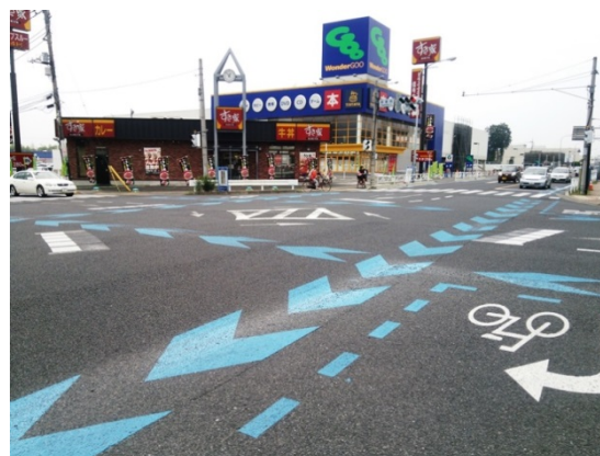
図-3 自転車走行空間表示設置状況(交差点部)
