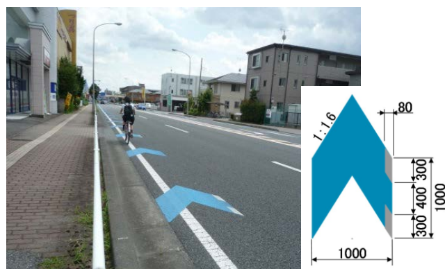
図-2 自転車走行空間表示設置状況(単路部)
