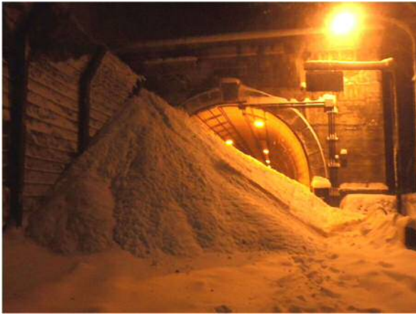
写真-3 女の湯トンネルの雪崩状況
