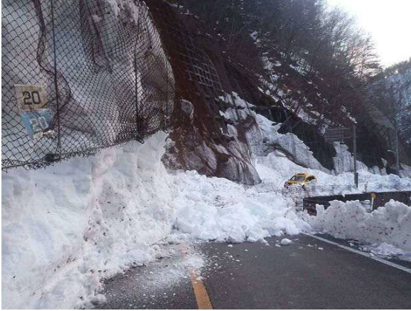
写真-13 除雪後の再雪崩の状況
