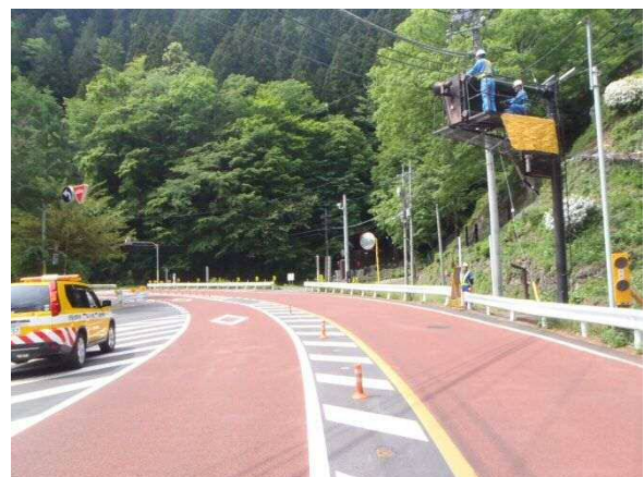
(解放後の大麦代トンネル坑口)
