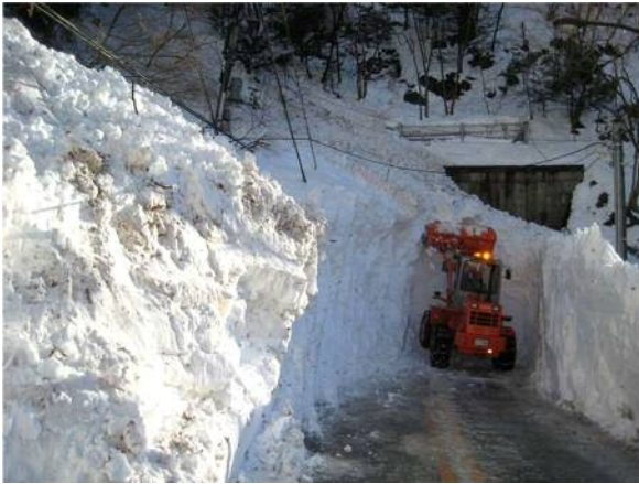
写真-10 坂本トンネルを除雪する契約業者
