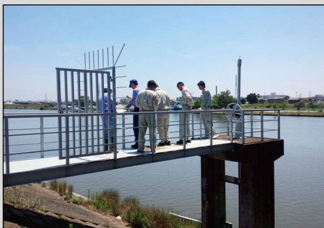
(中川左岸 23.7k 付近 道路排水樋管(三郷市))
