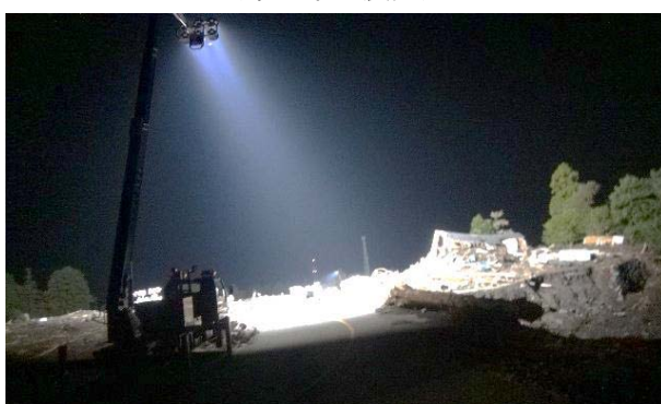
照明車による人命救助活動支援 （伊豆大島土砂災害）
