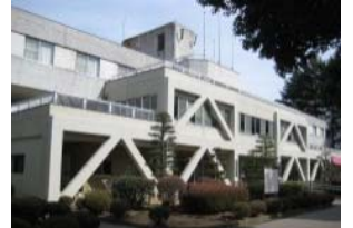
総合運動公園事務所(栃木県)
