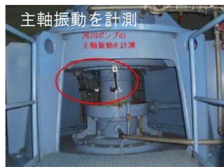
河川排水ポンプ施設の振動解析
