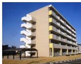
公営住宅整備事業(茨城県)
