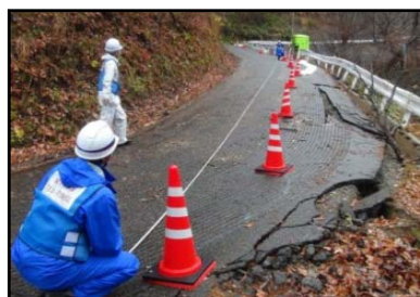
道路の被災状況調査
