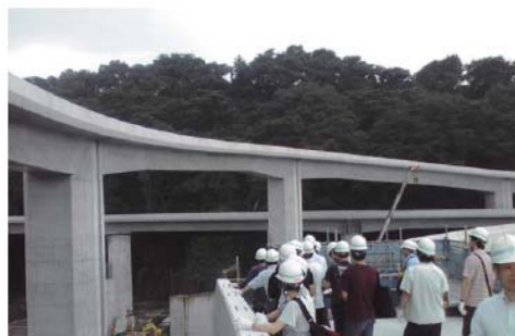
社会基盤整備について知っていただくための現場見学会
