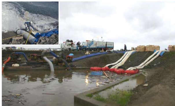
排水ポンプ車による排水 （東日本大震災）
