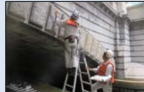
近接目視による橋梁点検
