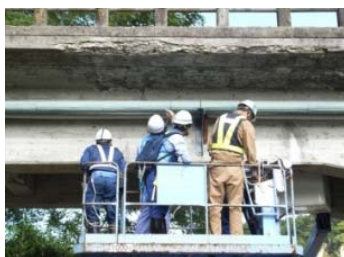
直轄診断（点検状況）
