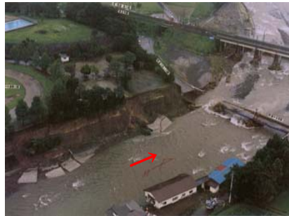
洪水によって流された中余笹橋(那須町)
