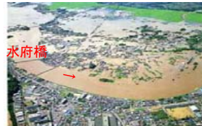
水府橋付近(水戸市)の氾濫状況
