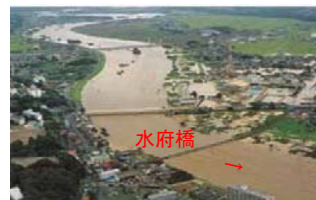
水府橋付近(水戸市)の氾濫状況
