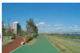
高規格堤防の整備によって市街地側は堤防とほぼ同じ高さに盛土
