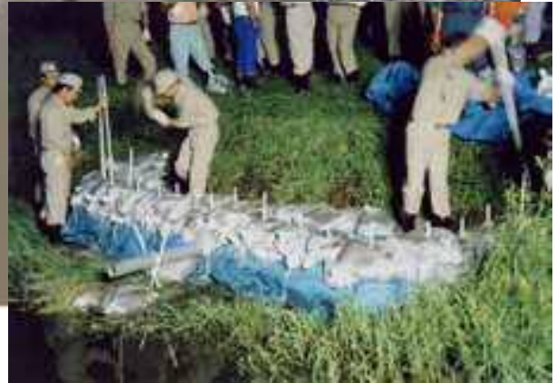
【平成10年9月 埼玉県加須市 漏水防止工法(月の輪工)】
