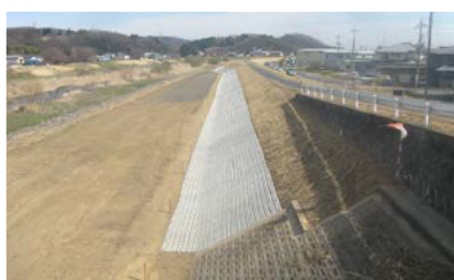
上濁沼橋下流付近の堤防法面完成風景
