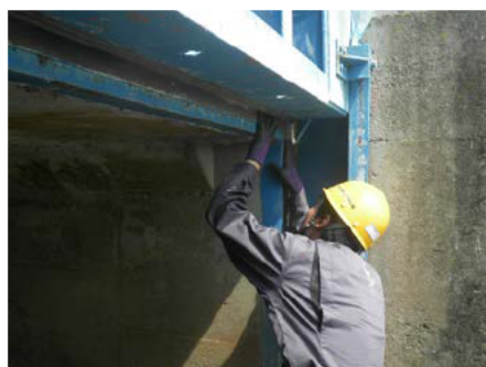
昨年度の樋管点検状況
