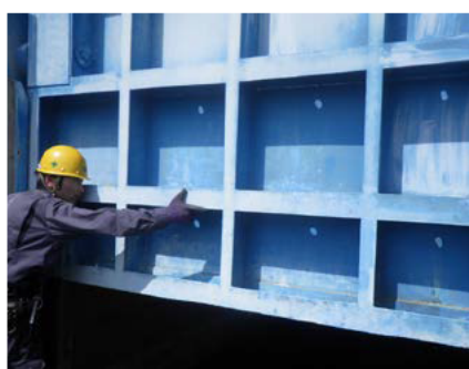
昨年度の樋管点検状況
