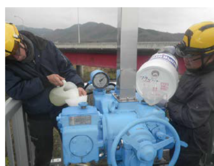
昨年度の樋管点検状況
