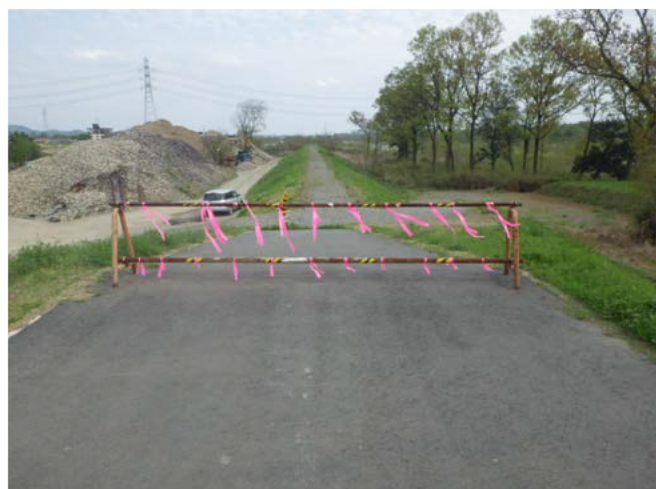
この先段差有り (簡易防護柵の設置)
