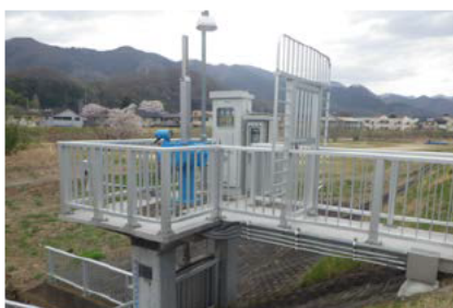
排水樋管の全景（堤防から撮影）
