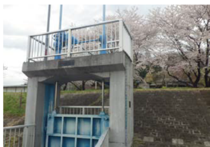
排水樋管の全景（川側から撮影）
