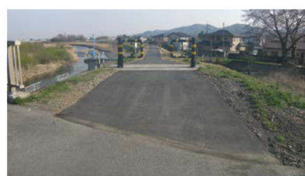
両国橋下流付近の堤防天端舗装完成風景
