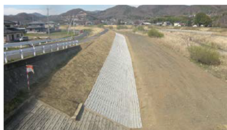
白髭濁沼橋上流付近の堤防法面完成風景
