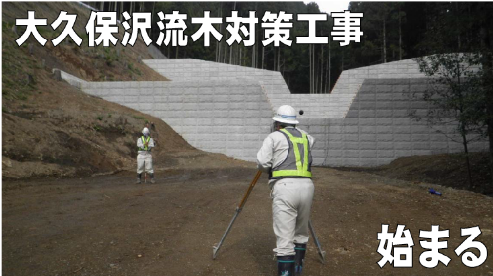
写真-3 H26大久保沢流木対策工事現場にて起工測量の様子=4月17日
