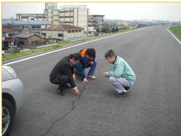
平成27年4月10日金曜日に堤防天端からの雨水浸透防止の目的を兼ねる「県道松戸・野田・関宿自転車歩行者専用道路」の舗装劣化状況調査を道路管理者である千葉県東葛飾土木事務所維持課と合同で実施しました。今後も、道路管理者と緊密に連携を図りながら、堤防への雨水浸透防止と歩行者や自転車が安全で快適に利用できる堤防天端の維持管理に努めていきます。
