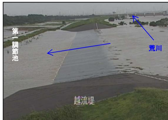
越流堤から流れ込む荒川の洪水流
