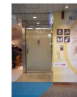
多機能トイレの設置
