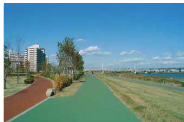
高規格堤防の整備によって市街地側は 堤防とほぼ同じ高さに盛土
