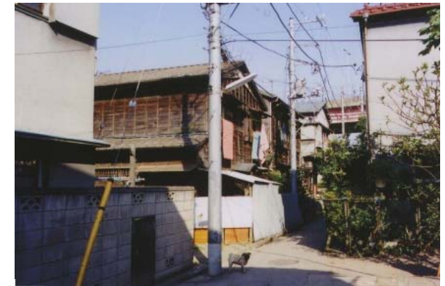
整備前は木造住宅等が密集し、道路整備が遅れ、 生活環境が悪化
