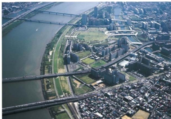
高規格堤防整備と併せて広大な公園や 中高層住宅等が整備
