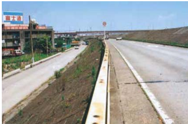
ゼロメートル地帯を守っていた高さ 約10mの荒川の堤防
