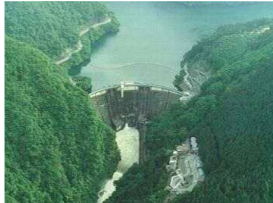
ふたせ 二瀬ダム (F,N,P) 治水容量 2,180万m 3 完成年 昭和36年
