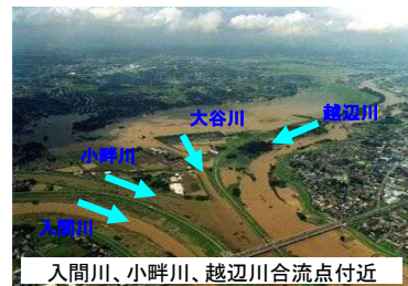
入間川、小畔川、越辺川合流点付近
