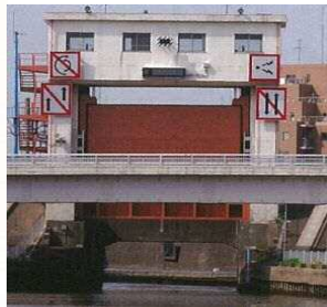
【船舶の通航方法の例】 河川標識
