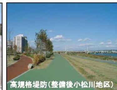
高規格堤防(整備後小松川地区)
