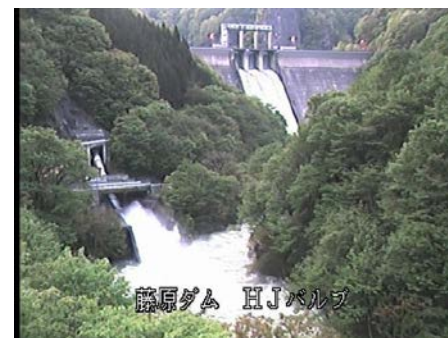
緊急放流の様子(藤原ダム)
