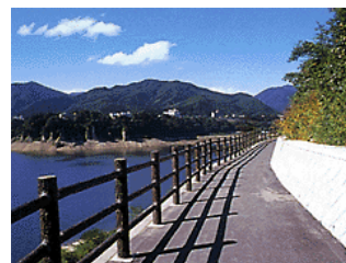
相俣ダム周辺施設 (遊歩道)
