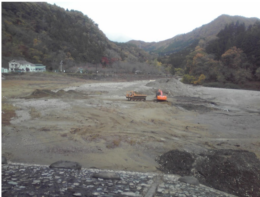
堆砂の掘削・搬出作業 (H21. 11)
