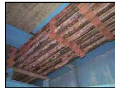
橋梁下面の添架物の腐食
