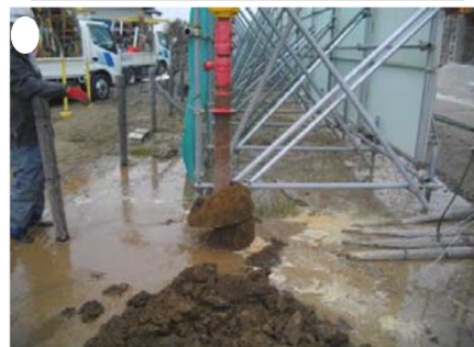
建柱車(オーガ)掘削状況写真
