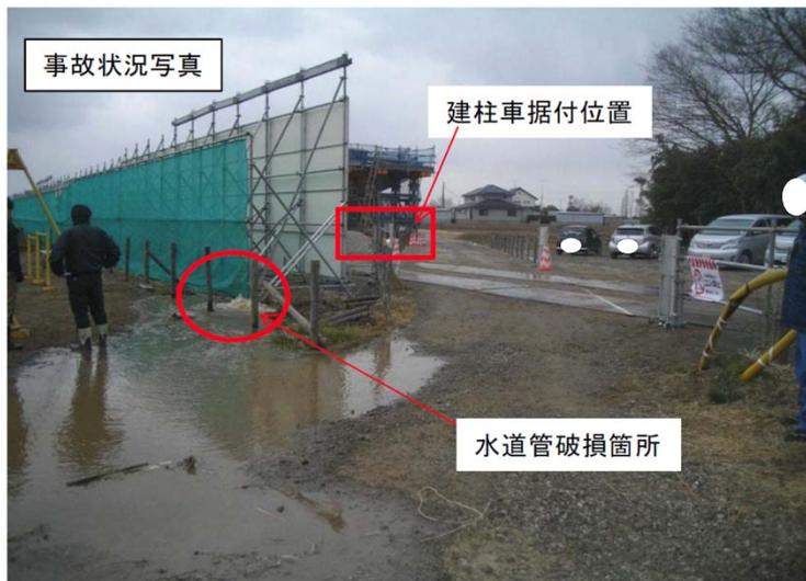
・現場仮設電源設置において引き込み電柱を建柱するため建柱車(4t)にて建柱箇所を約2m掘削した。
