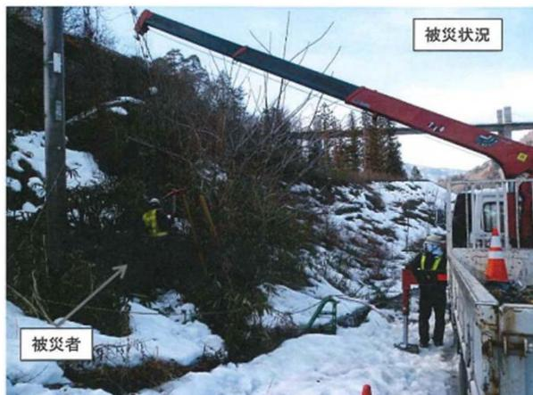
・通信架空配線の架空部分を撤去した後、支線上部の取り外しを行い、支線下部の撤去作業を開始した。
