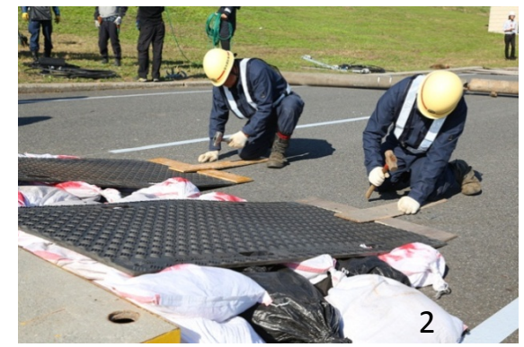
◆土のうの積上げ等による橋梁段差を解消する
