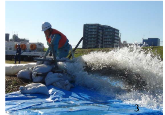
◆排水ポンプ車による排水
