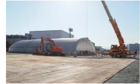
◆液状化した地盤の応急復旧訓練(東扇島)
