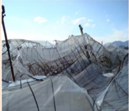
大雪により倒壊した農業用ハウス(山梨県甲州市)
