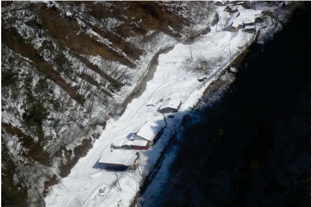
①県警ヘリより当部職員撮影：鉱山事務所道路の積雪状況
