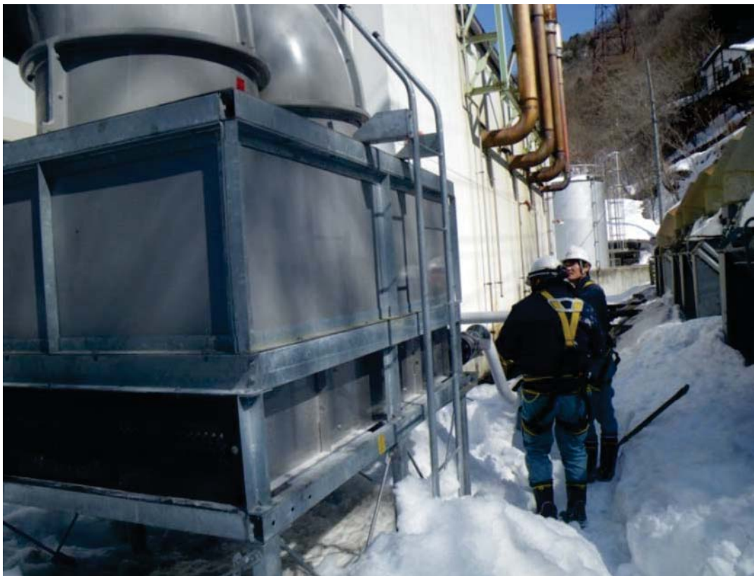
②当部職員撮影：発電所冷却機の調査
