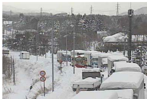
【国道18, 20号の除排雪状況】
