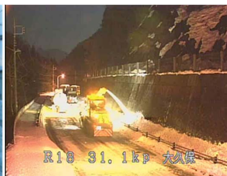
国道18号 碓氷BP 除雪作業
