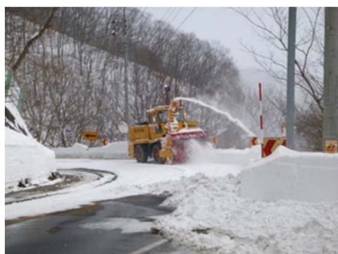
国道17号 みなかみ町 除雪作業
