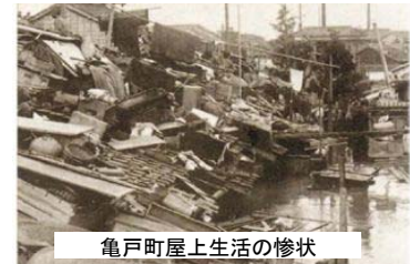
亀戸町屋上生活の惨状
