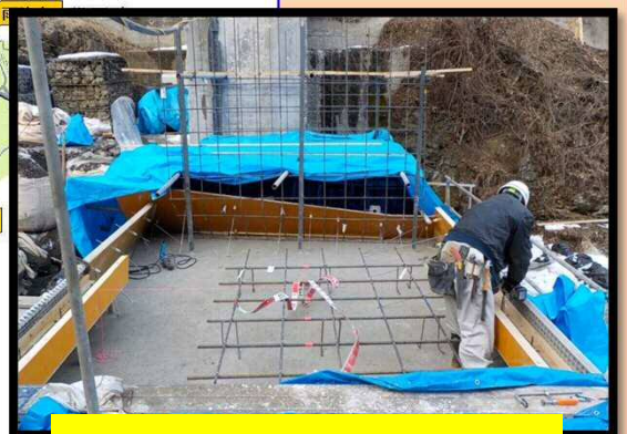
H26中ノ沢第一砂防堰堤改良工事 (多野郡上野村大字檜原地先)
