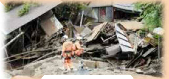
7月 土石流による被害 (国土交通省HPより)
