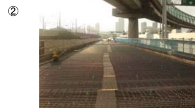
② (床版鉄筋設置中)
