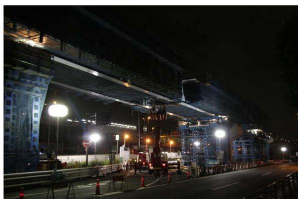
縦送りによる新木場料金所出口の架橋工事
