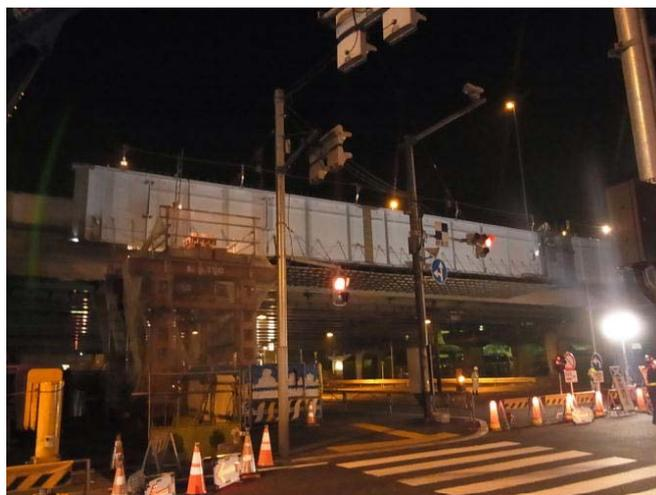
夢の島交差点上の桁架設作業
