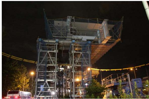
横送りによる新木場料金所入口の架橋工事
