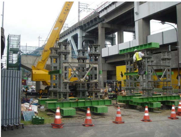
ベント設置工事
