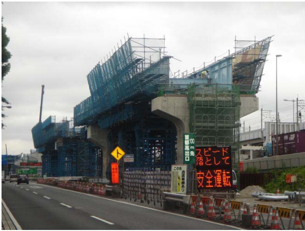
架設の終了した上部工
