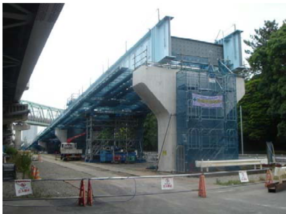
架設の終了した上部工
