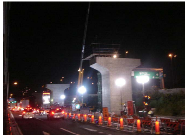
夜間の足場設置作業
