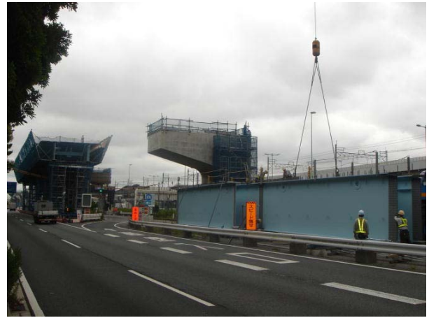
架設中の桁
