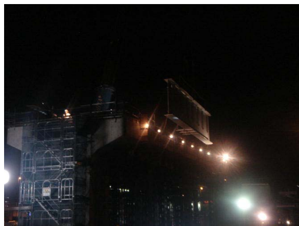
夜間の上部工（桁）架設作業
