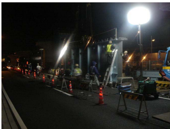
夜間の上部工（桁）架設作業
