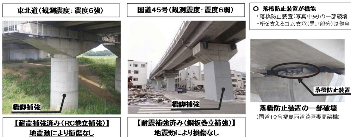
写真 1 東日本大震災の被害状況
