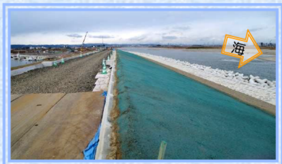
【河口部における堤防復旧工事】
