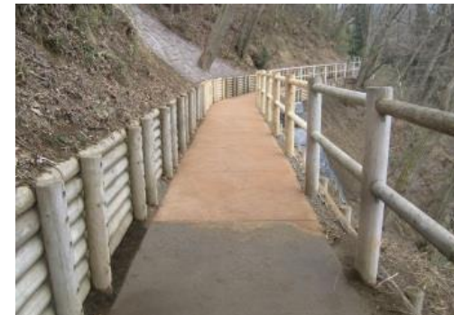
群馬県産の間伐材を利用した遊歩道の整備
