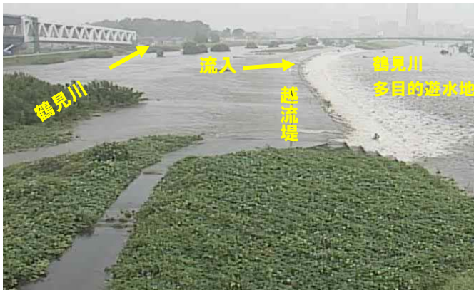
鶴見川の水位が上昇し、越流堤から鶴見川多目的遊水地に流入
