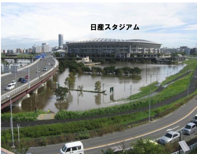
過去最大となる154万m 3 を貯留した鶴見川多目的遊水地
