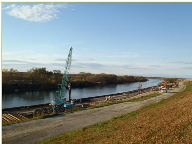
流山市三輪野山地先において、平成26年11月より工事に着手し、11月末時点での工事進捗率は約38%、現在は、広幅網矢板(左下写真は、打設機械による打込作業)、袋詰玉石、盛土、土砂改良を鋭意施工しています。(右下写真は、現場を見渡す見晴台、左写真は、平成26年12月7日時点の現場状況です。)
