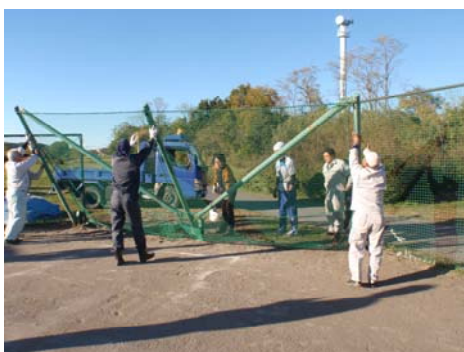
撤去可能か確認
