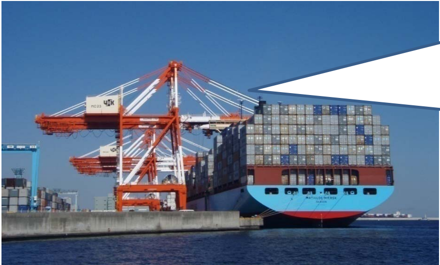
【横浜港南本牧ふ頭に設置されたガントリークレーン】
