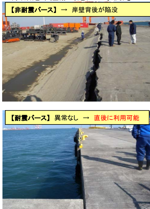
【東日本大震災における岸壁被災状況 (茨城港常陸那珂港区の事例)】
