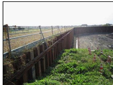
鋼矢板二重締切工法
