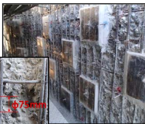
鉄筋での補強状況
