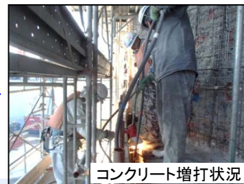
コンクリート増打状況
