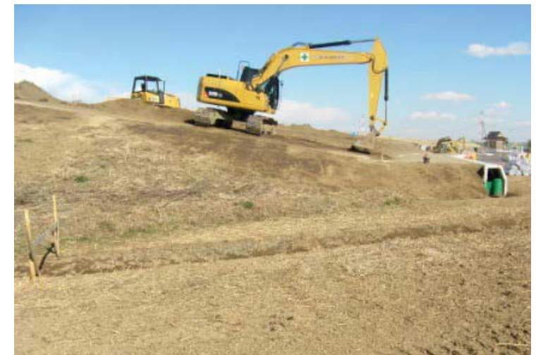
築堤盛土状況
