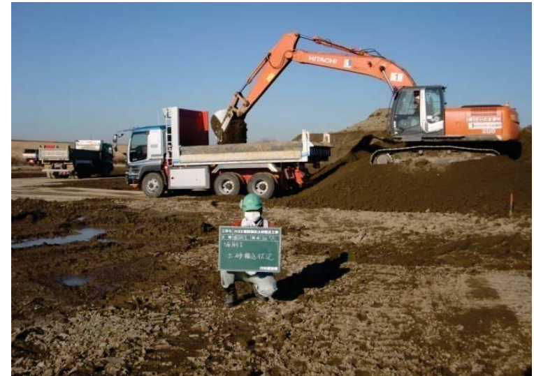
掘削土の積込・運搬
