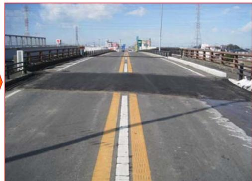
写真 序-14 国道357号(千葉県浦安市)路面段差
