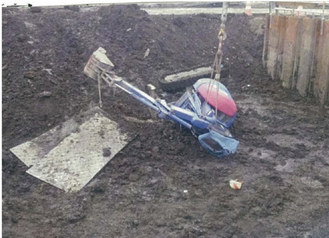
・橋梁下部の掘削中にミニバックホウが転倒し、オペレーターが機械の下敷きになり、死亡した。(詳細調査中)
