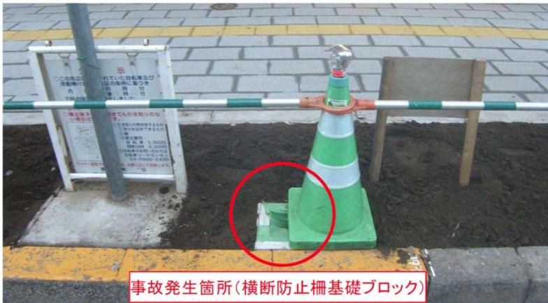
・新設した植樹帯の中に、横断防止柵基礎を設置し、カラーコーンとコーンバーで侵入防止措置を行っていた。
