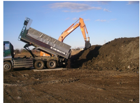
現場発生土を築堤材料として再利用
