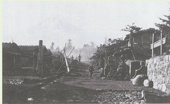
道路改修前の状況
