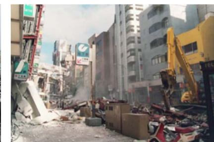
写真 震災により通行できない道路 (神戸市中央区) [出典: 神戸災害と戦災資料館(神戸市HP)]
