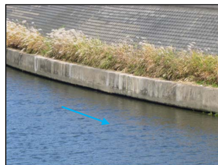
高水敷のない直立護岸で水辺に近づけない
